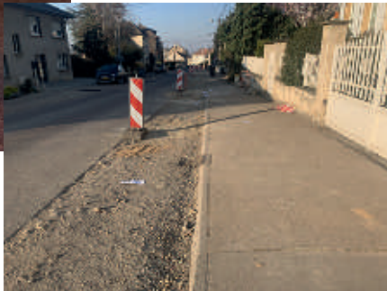
Intervention de réparation sur le réseau d'eau rue Jules Samson
