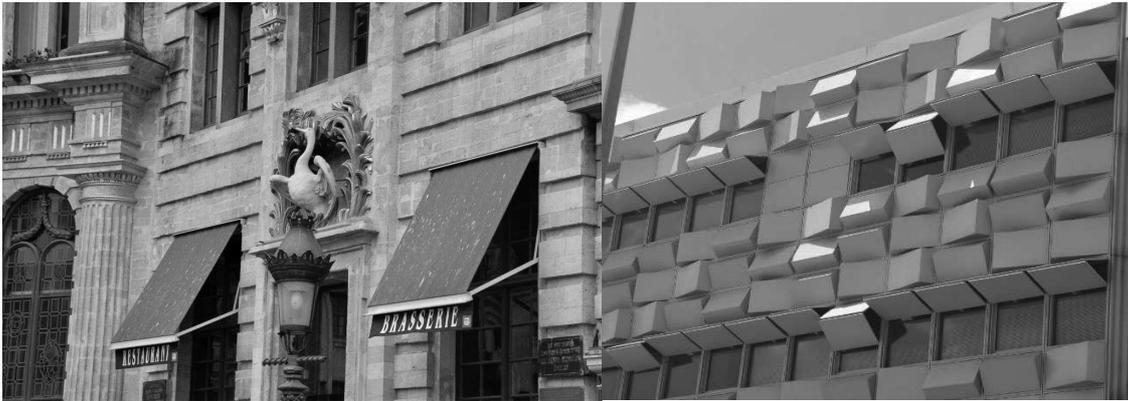
Figure 17 : Gauche : dispositif de type « marquise » – Droite : exemple de protection escamotable (source : unsplash.com)
