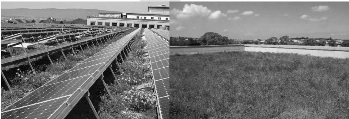
Figure 24 : Toiture « Bio-solaire » du Palais de Beaulieu à Lauzanne à gauche et toiture végétalisée d'un bâtiment tertiaire à Metz (source : [naturetoit.blogspot.com](http://naturetoit.blogspot.com) et AGURAM)
